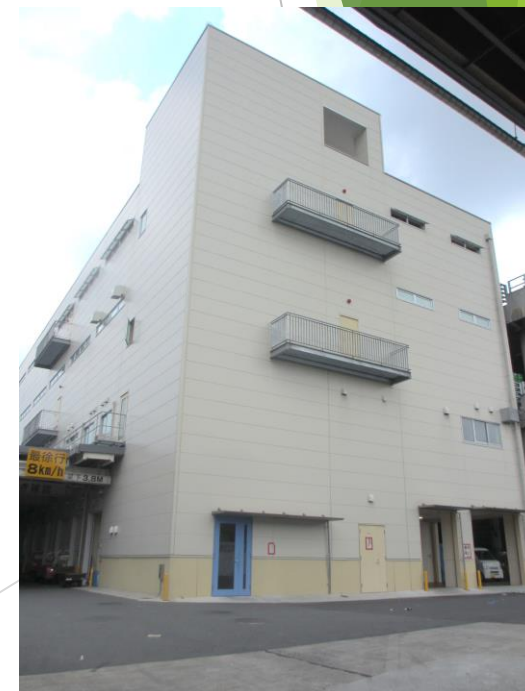
市場リニューアルの推進(新設された仲卸棟)
